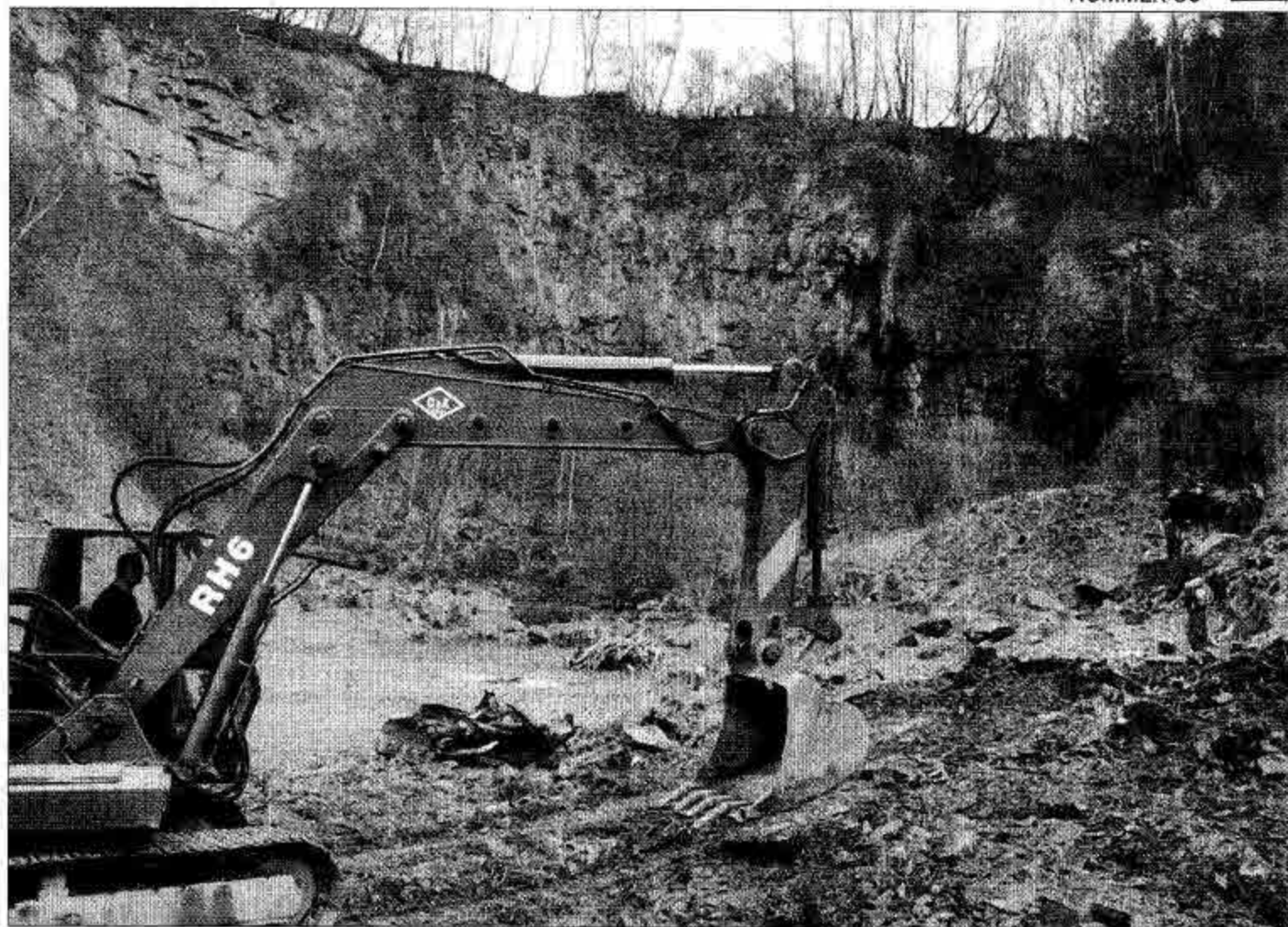
Mit dem Bagger wird im ehemaligen Steinbruch, wo Bauschutt und Bodenaushub deponiert wurden, aufgeräumt. (Fotos: Röhrig)
